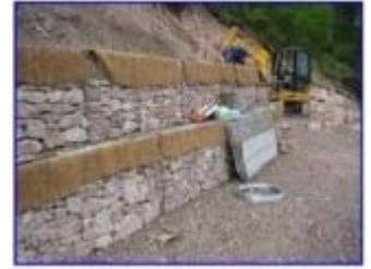
Durante il collocamento vengono posti in opera i tiranti di attraversamento che riuniscono le pareti e le testate, per evitare che la spinta del pietrame deformi il gabbione oltre la sagoma. Una volta terminato il riempimento, viene effettuata l'operazione di cucitura del lato superiore del gabbione, mediante filo in acciaio zincato. Man mano che i gabbioni vengono costruiti, sono legati fra di loro.
