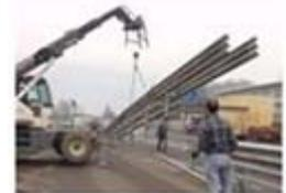
Solitamente lo stesso autocarro adibito al trasporto materiali è equipaggiato di gru idraulica di servizio: tutti i componenti vengono scaricati a terra e distribuiti lungo la linea di posa.
