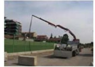
Lo stesso procedimento si adotta nell'infissione dei pannelli fonoassorbenti, che vanno a costituire la barriera fonoassorbente, dentro le guide formate dai montanti a doppio T. Generalmente le altezze per le barriere fonoassorbenti variano da 3 a 5 metri.
