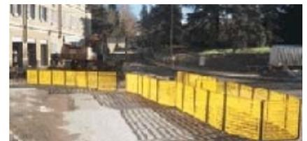
Fasi previste: Infissione paletti nel terreno e sistemazione rete di plastica; preparazione delle buche mediante scavo manuale con badile per porre in opera le colonne di sostegno delle ante dei cancelli e getto del calcestruzzo, previo ancoraggio, con elementi di legno delle colonne stesse. Collocazione su appositi supporti dei cartelli segnalatori con l'uso di chiodi, filo di ferro, ecc.
