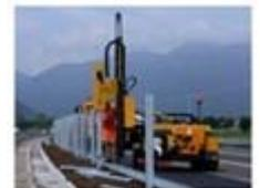
La posa in opera dei montanti avviene fissando i profilati all'interno dei fori con sabbia e calcestruzzo.
